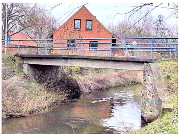
Die Klappenburgbrücke von Süden. Man erkennt die heutige Beton-Fertigteilkonstruktion, die an den Ufern von den alten Brückenglagern umschlossen ist. Rechts unten ragt noch ein Relikt der ehemaligen Abwasserentsorgung aus der Mauer.
