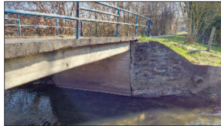
Die Auebrücke an der Klappenburg aus dem Jahr 1900 ist die älteste Brücke in der Stadt Petershagen.
